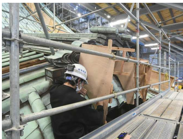
向拝の軒唐破風曲線実測
