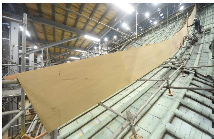
やだるみ 正面屋根の屋垂み実測
